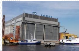
МОРСКОЙ ИСПЫТАТЕЛЬНЫЙ КОМПЛЕКС НА ТЕРРИТОРИИ СУДОСТРОИТЕЛЬНОЙ ФИРМЫ «АЛМАЗ»
